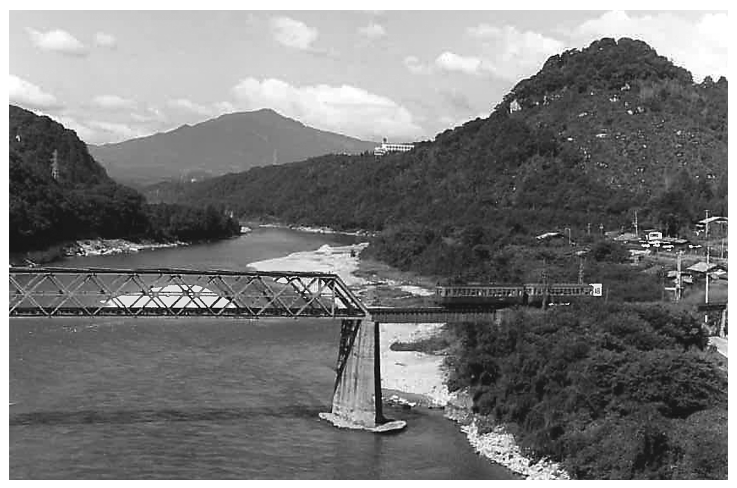
廃線前の「木曾川橋梁」
